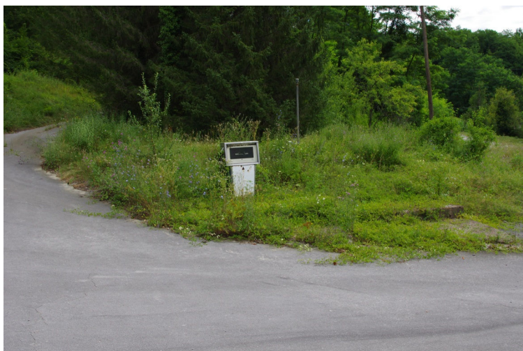
10. Crpka za gorivo sa podzemnim spremnikom
