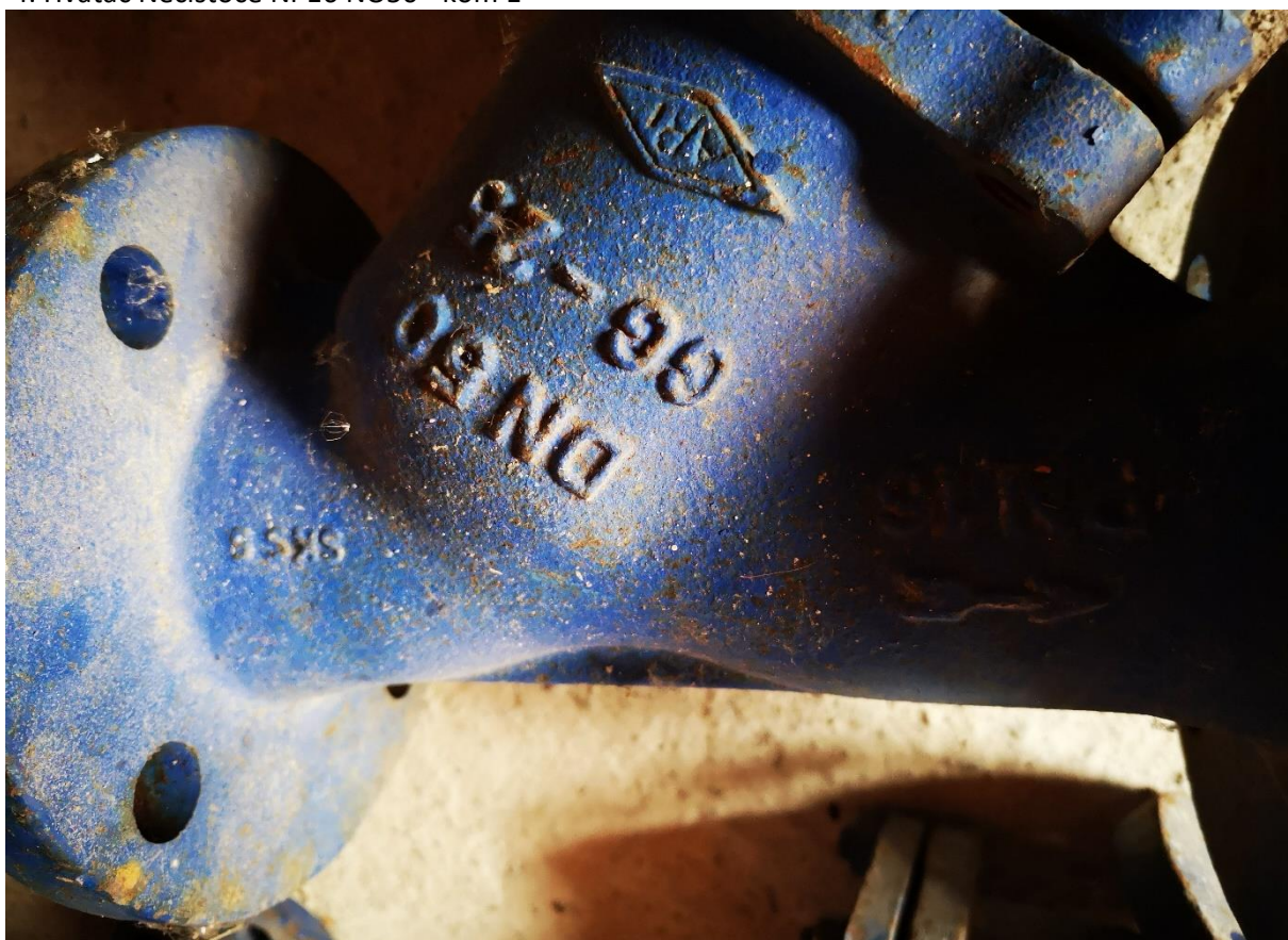
4. Hvatač Nečistoće NP16 NO50 - kom 1
