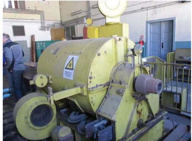
Ad 159 i 167 Pretvaračka grupa BBC BR.3 V S i Ormar raskl.za mot.BBC
