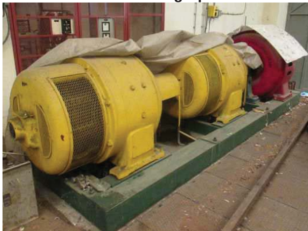
Ad 159 i 167 Pretvaračka grupa BBC BR.3 V S i Ormar raskl.za mot.BBC
