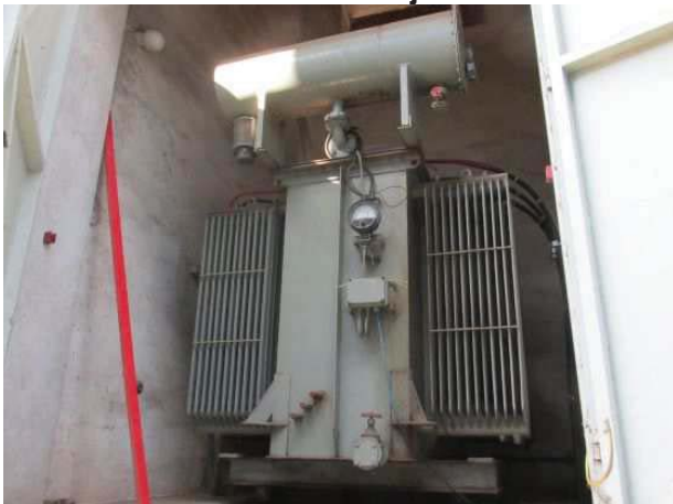
Ad 58 Transformator trof.uljn.10/6KV
