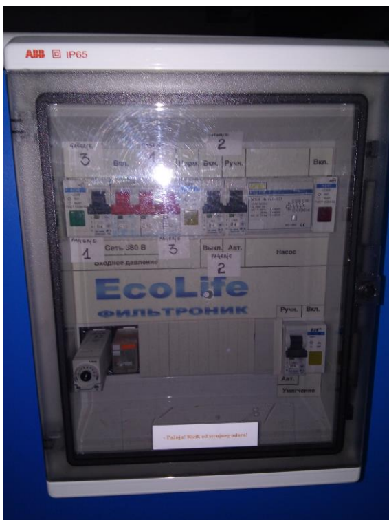
Sustav za omekšivanje vode, upravljački ormar, mješači, dozatori
