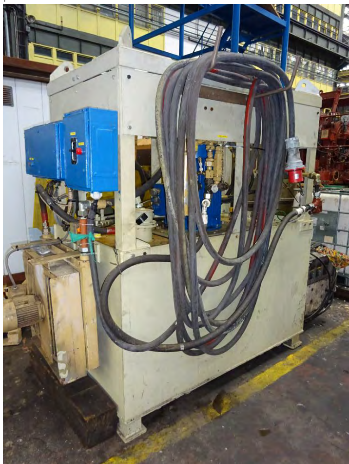
... 591. .... • HIDRAULIČNI AGREGAT... ..... A2P-300..
